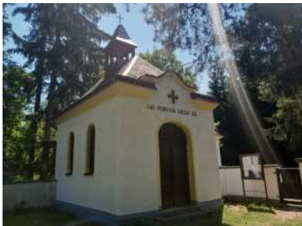
Opravená hřbitovní kaple
